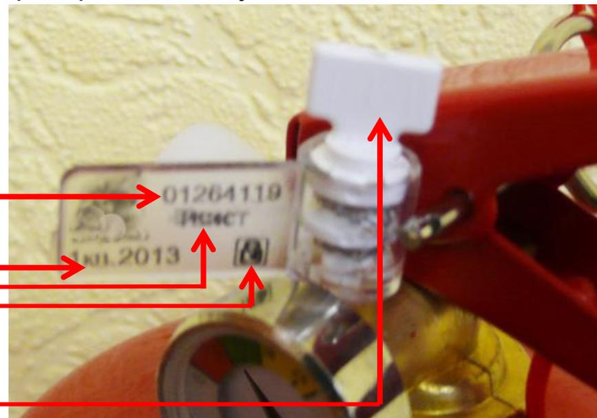
Контрольные пломбы с ротором белого цвета используются для опломбирования огнетушителей, произведенных заводом-изготовителем.
